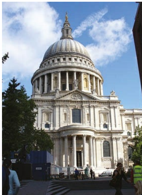
Christopher Wren. Catedral de San Pablo. Fachada sur del crucero, inspirada en Santa María della Pace de Roma por su diseño semicircular convexo que sobresale hacia el exterior.
